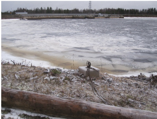
Kuva 19. Etelärannan vanhan uittopuomin betonikiinnike (Alatalo 2017)
