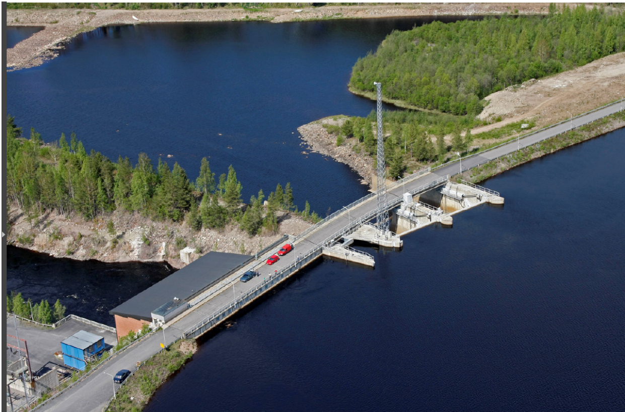
Kuva 1. Haapakosken voimalaitos (kuva: PVO-Vesivoima Oy)
