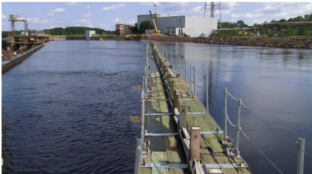
Kuva 11. Grand Fallsin voimalaitoskanava ylävirtaan päin kuvattuna. Kelluva säleikkösuuntaaja kävelytasolla varustettuna.
