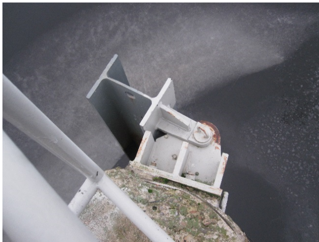
Kuva 20. Haapakosken voimalaitospadon uittoaukon viereinen virtapilari (Alatalo 2017)
