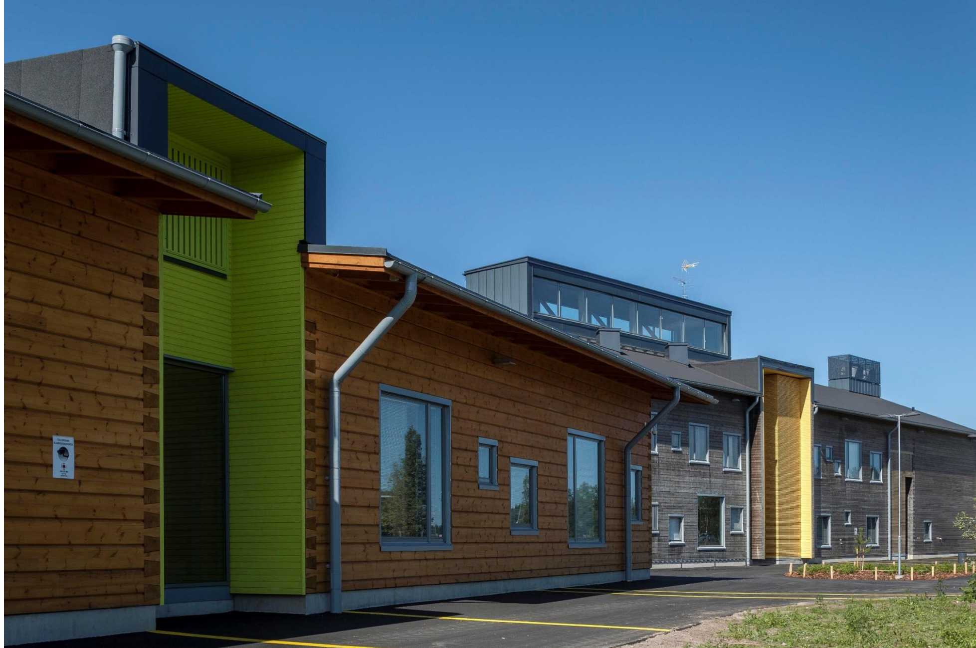
Pudasjärven hirsikampus, Arkkitehtitoimisto Lukkaroinen, 2016
