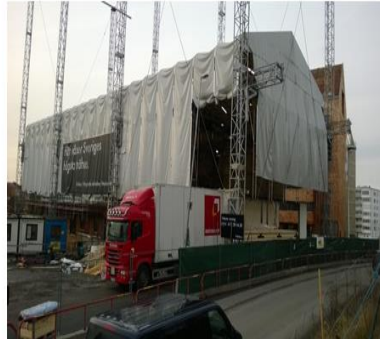
Materiaali suoraan sääsuojauksen sisälle, suoja nousee kerrosten rakentuessa ylöspäin
