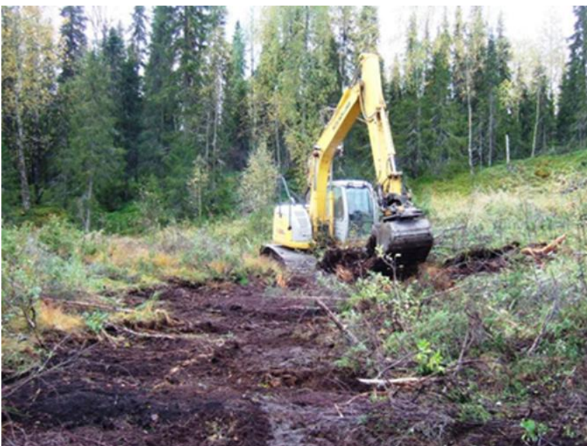
Kuva 18. Suon ennallistamista kaivinkoneella
