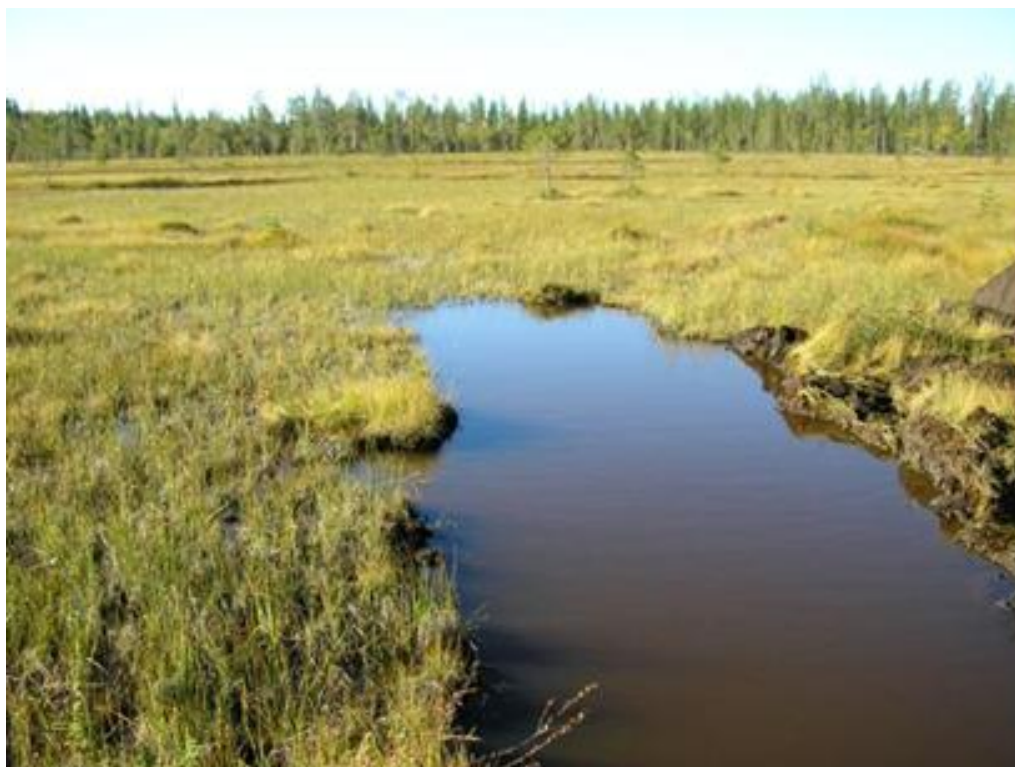
Kuva 17. Laskeutusallas ja pintavalutuskenttä yhdistettynä ovat tehokas vesiensuojelumenetelmä
