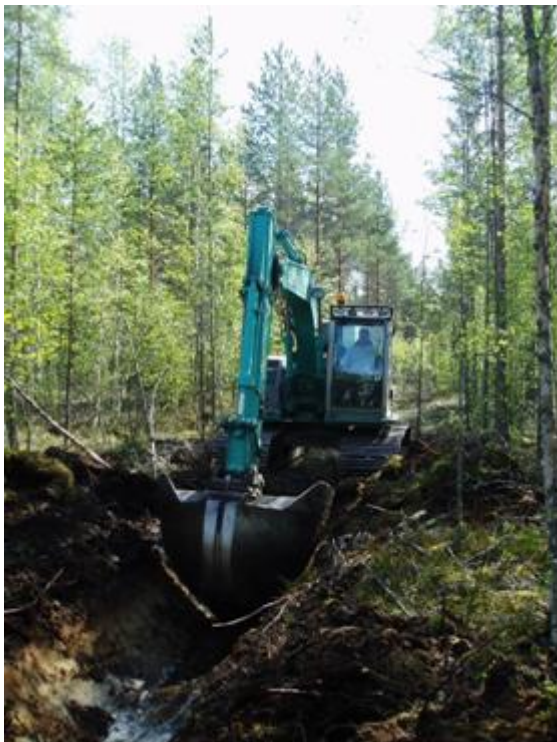
Kuva 12. Kaivuri työssään kunnostusojitustyömaalla. Turvekangas on ohutturpeista puolukkaturvekangasta (Ptkg I)
