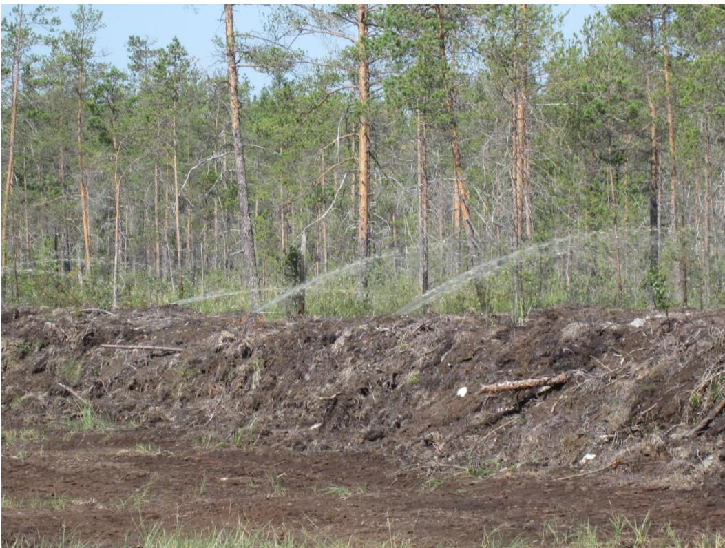
Kuva 2. Turpeennostoalueelta tulevaa vettä pumpataan pintavalutuskentälle.
