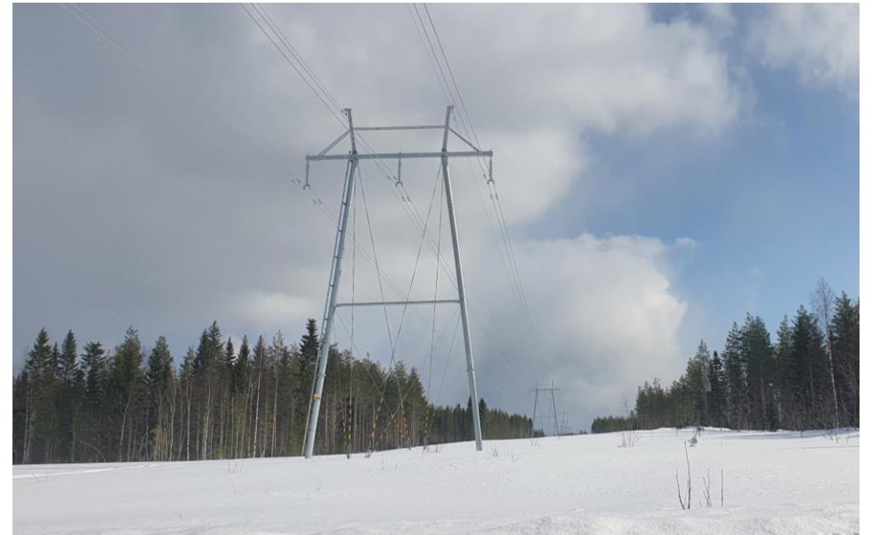
Kuva 8. Esimerkki 110 kV -voimajohtoon maastokäytävästä. © Sweco.
