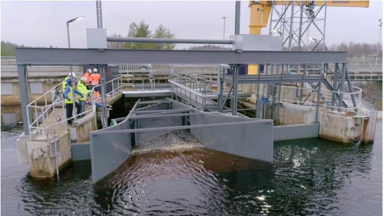
Kuva 1: Smolttien alasvaellusväylän suuosaa kuvattuna ylävirrasta päin. Vedenalaiset kamerat tulee sijoittaa suppilon vastakkaisille reunoille nielun "niskalle". Kuvassa ei ole suppiloon keväällä asennettavaa pitkittäissuunnassa olevaa muovilevyä.
