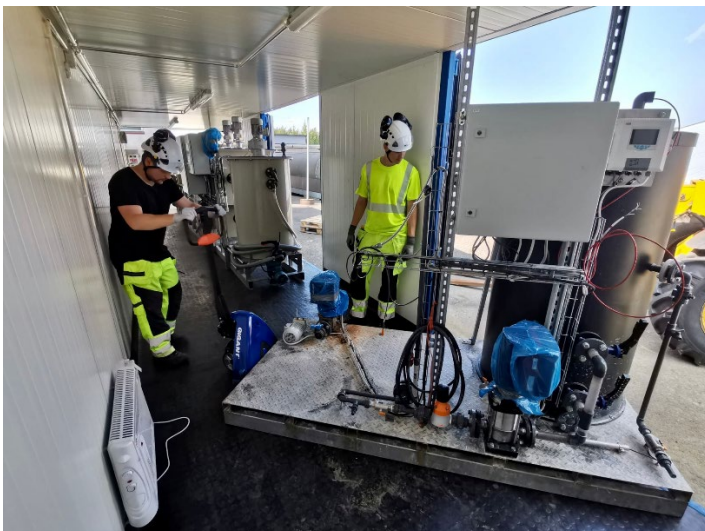
Kuva 1. Pilot laitteiston rakentamista Pyhäsalmissä
