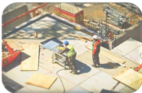
Rakennusala talonrakennus, 10-160 pv
