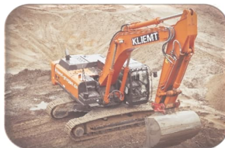
Rakennusala maanrakennus, 10-160 pv
