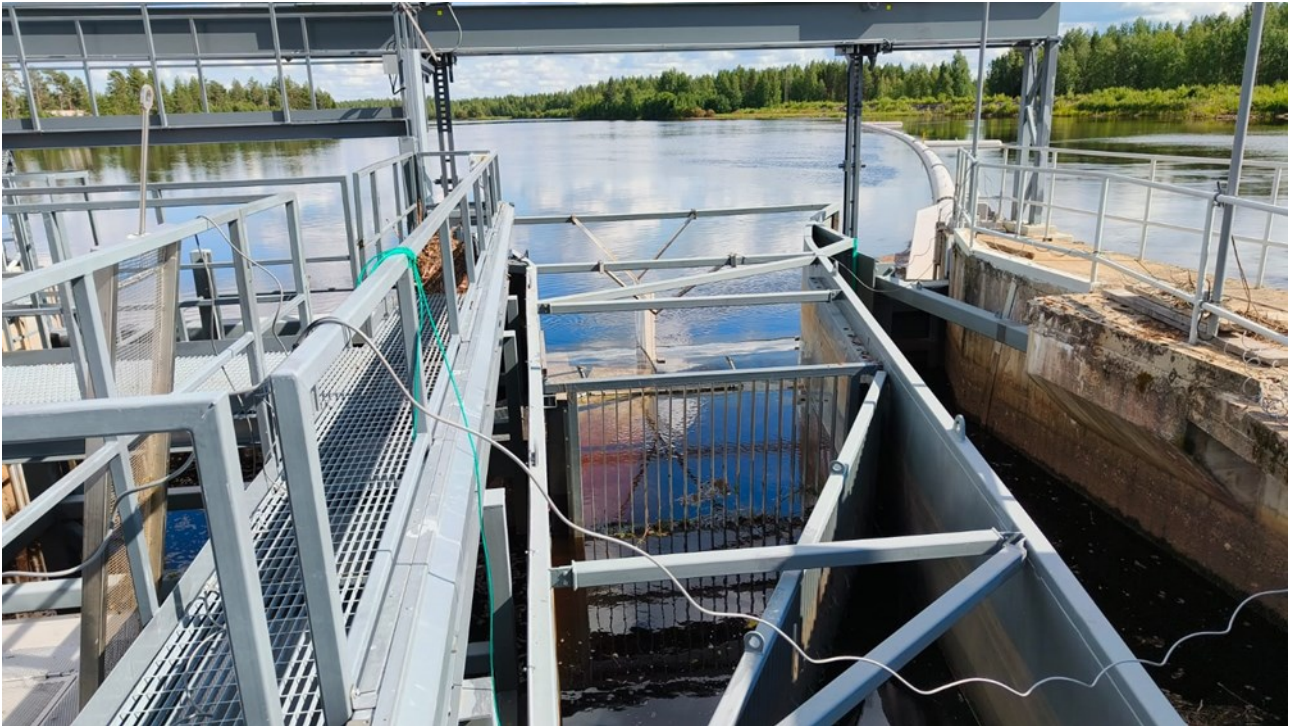
Kuva 4: Haapakosken alasvaellusväylä ylävirtaan päin kuvattuna kesällä 2024. Suppilon keskellä näkyy kaudelle 2024 asennettu harva roskavälppä.
