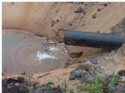
Kuvat 10-13. Matkakankaan metsätien alittava uusi putki, joka on halkaisijaltaan puoli metriä.
