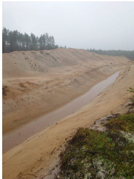
Kuva 2. Matkakankaalla oleva uusi syvä veto-oja, joka saa alkunsa kaivannon Meriänjärven puoleisesta päädyistä. Koko kangas on halkaistu kyseisellä ojalla.
